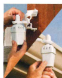
Sensor mit Halterungen installieren
